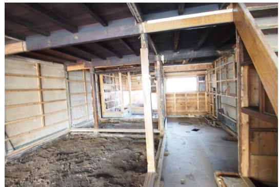
1階 内装・設備解体撤去済み
