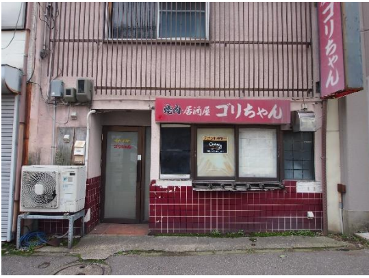
店舗改修工事前
