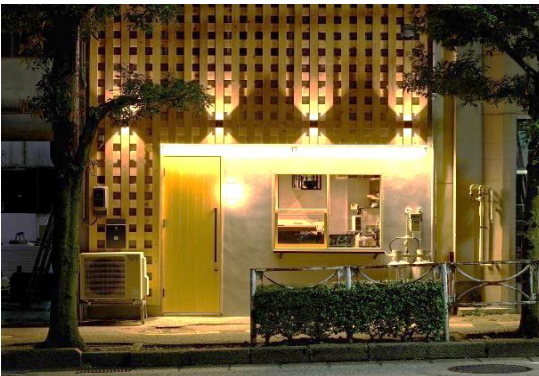
店舗改修工事後
